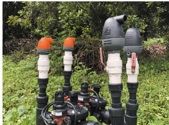
Trạm điều khiển sử dụng dòng van 200
