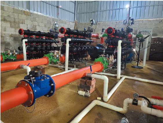
Trạm điều khiển sử dụng dòng van 400
