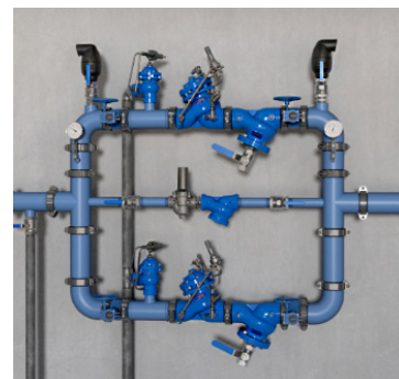
Hình 4.8 - Trạm giảm áp trên sàn
