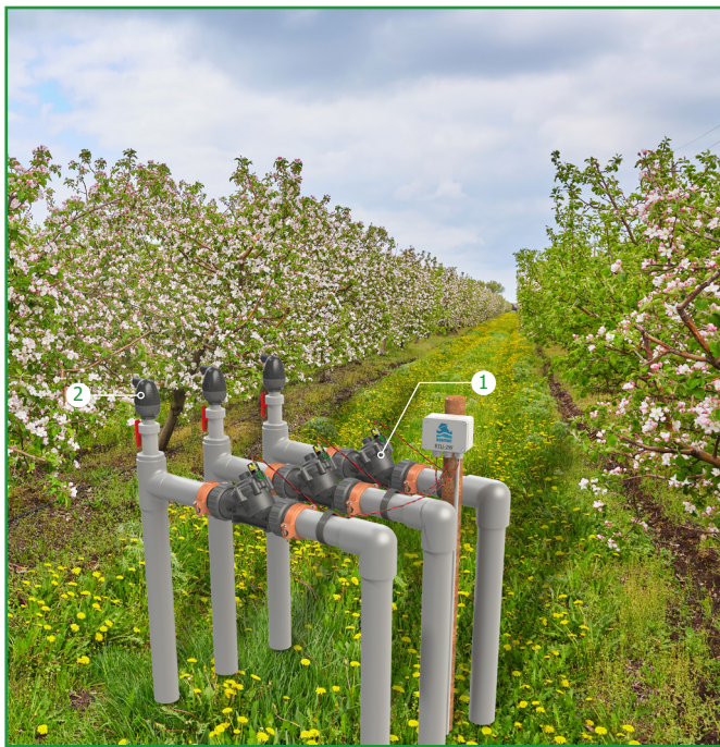
[1] BERMAD รุ่น IR-11T เปิดและปิดตามคำสั่งทางไฟฟ้า [2] วาล์วอากาศแบบผสม
