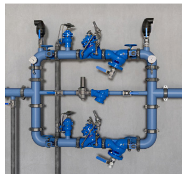
ภาพที่ 4.8 - สถานีลดแรงดันตั้งพื้น
