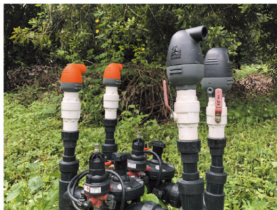
หัวจ่ายในไร่ใช้วาล์วรุ่น 200-ภาคใต้ของจีน
