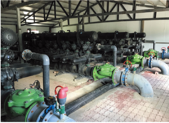
การควบคุมหัวจ่าย-พื้นที่ปลูกกล้วยกว้างสี่
