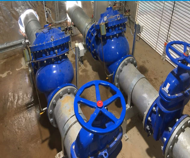
Nước Úc - Hệ thống Cấp nước Tasmania
