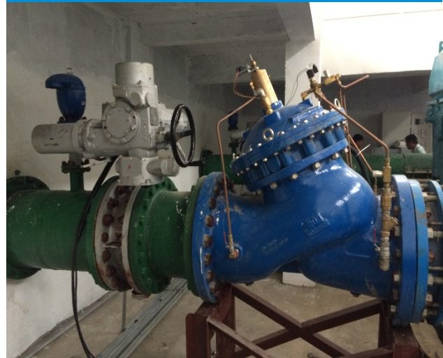
Trung Quốc - Hệ thống Cấp nước Renhuai
