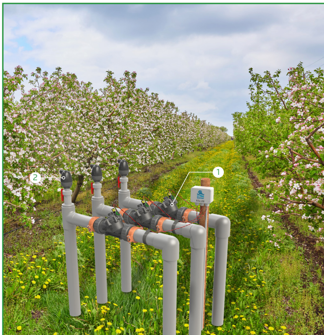
[1] BERMAD Model IR-11T membuka dan menutup berdasarkan perintah listrik [2] Katup Udara Kombinasi
