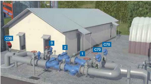
Gambar 4.3 – Sistem Pengurang Tekanan Redundansi Penuh
