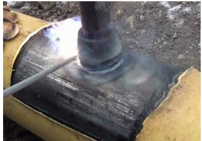
Adaptador com rosca sendo soldado em tubo, registro será roscado posteriormente.
