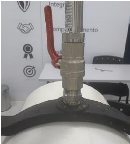
Registro roscado no colar de tomada através de um niple de 1".
